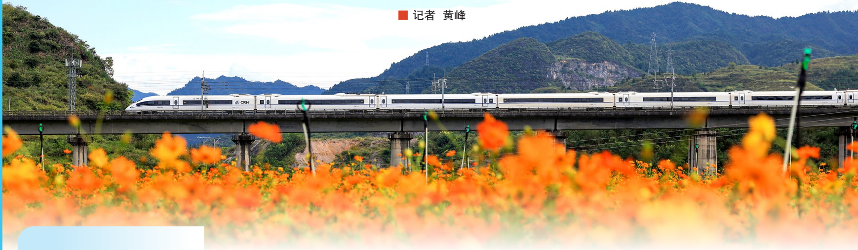
9月17日,凯里市龙塘花海小镇鲜花盛放,一列复兴号动车组驶过高架桥梁。通讯员 梁辉波 摄(影像贵州)
