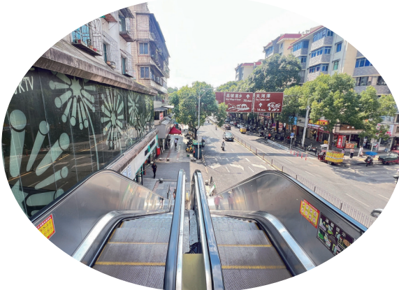
花溪区清溪路与贵筑路交会处人行天桥自动扶梯恢复运行。
