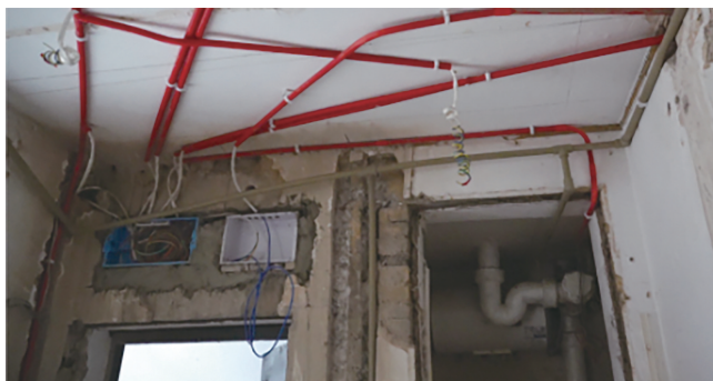
王先生家中水电施工仅铺设了空管和管线。
