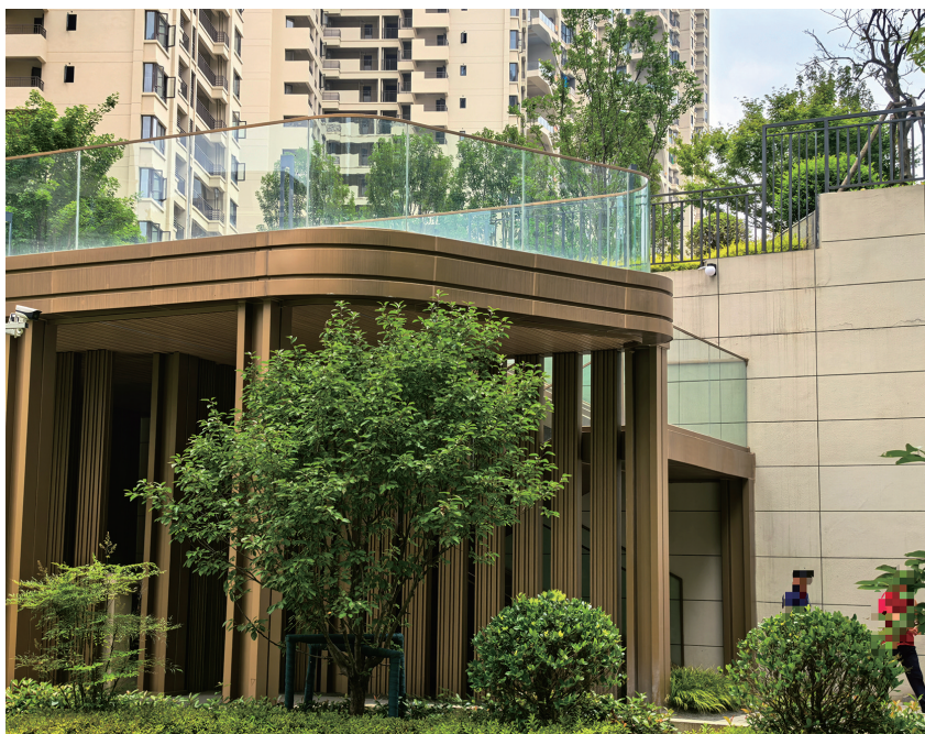
2号地块围墙分隔处步行楼梯。
