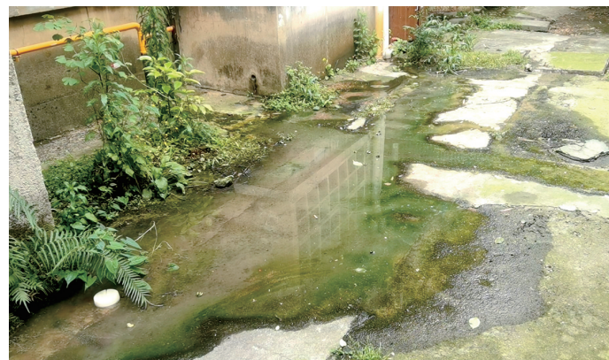
地面存积的大片污水。
