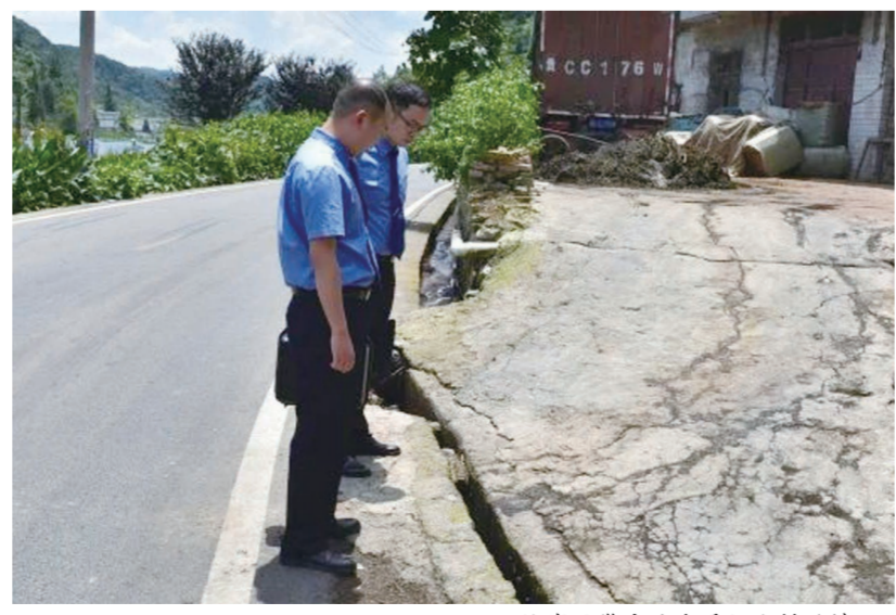
检察官实地查看污水排放情况。
